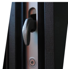
crémone à crochets anti-dégondage
