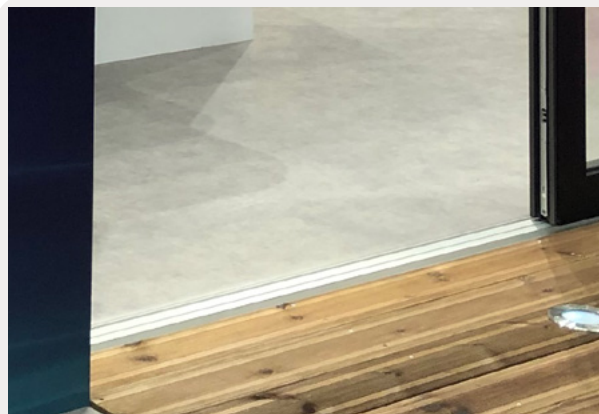
Seuil en fibre de verre encastrable - accès Personne à Mobilité Réduite (4mm de débord)
