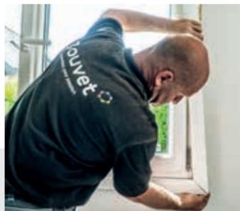
Pose des ailes de recouvrement
