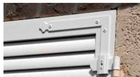
LE FERRAGE RÉNOVATION
