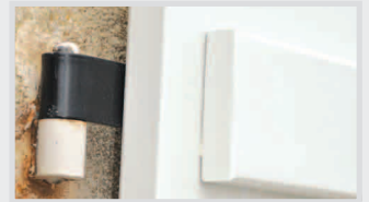
PLIAGE DES PENTURES : adaptation aux gonds existants
