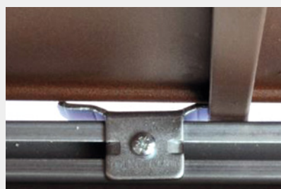
CROCHETS DE RAPPEL HAUTS ET BAS
